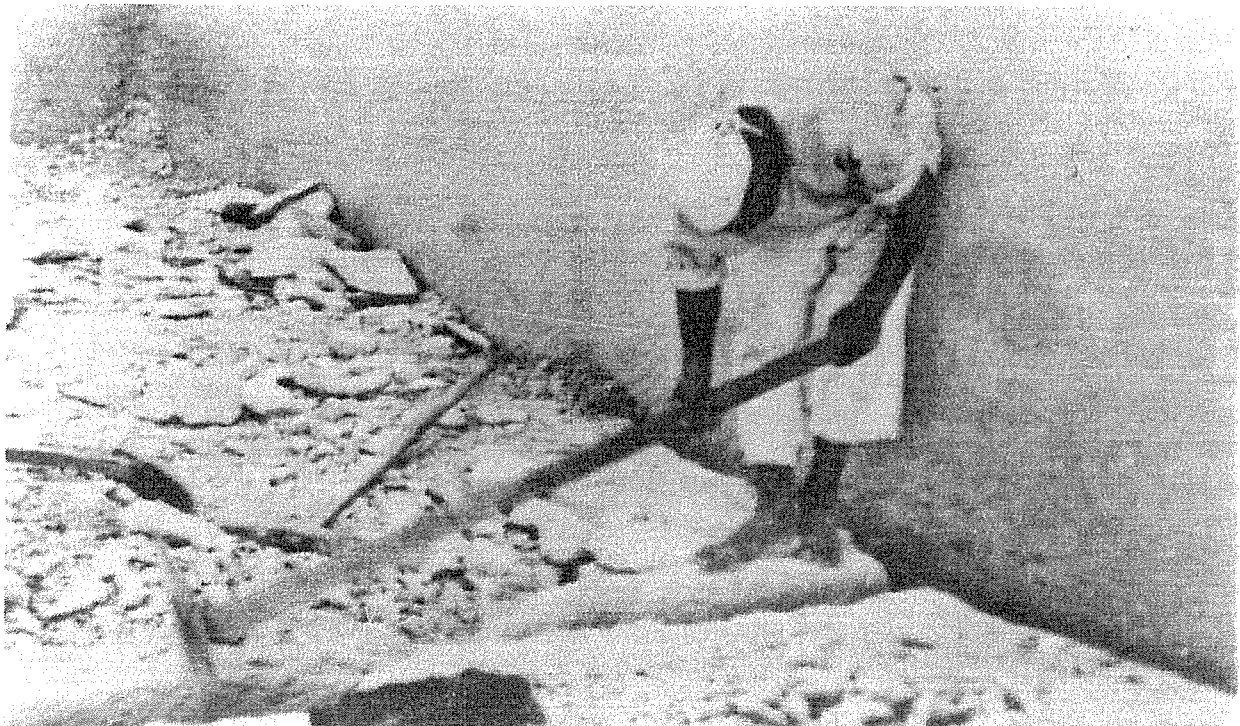
Trinkatur, miwi ganċ, iħaffer bil-baqun it-trinka ta' madwar it-traversa.
